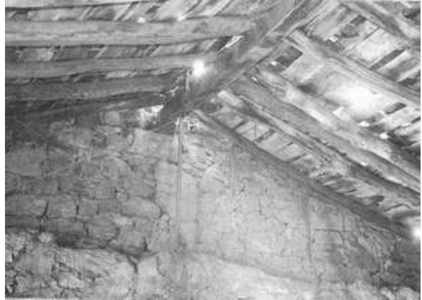
6. Detalle del entramado y adelgazamiento del muro
