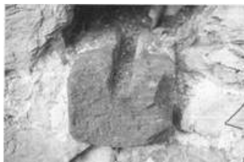
8. Detalle del desagüe (planta baja, fachada Sur)
