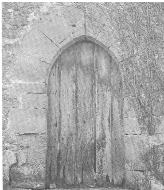
Puerta ojival (fachada Norte)
