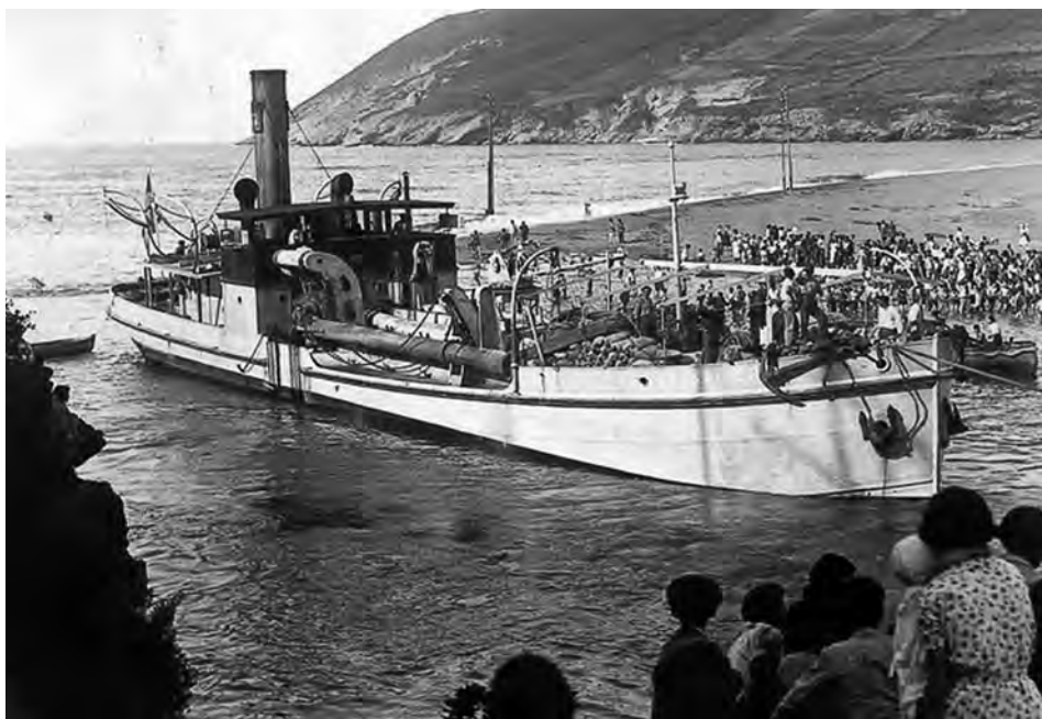
Bokalea dragatzea eta harri-lubetak eraikitzea izan ziren uholdeek eragindako kalteak gutxitzeko sustatu ziren jarduketak. "Euskal Erria" draga, Barbadun ibaiaren bokalean lanean (1931).
