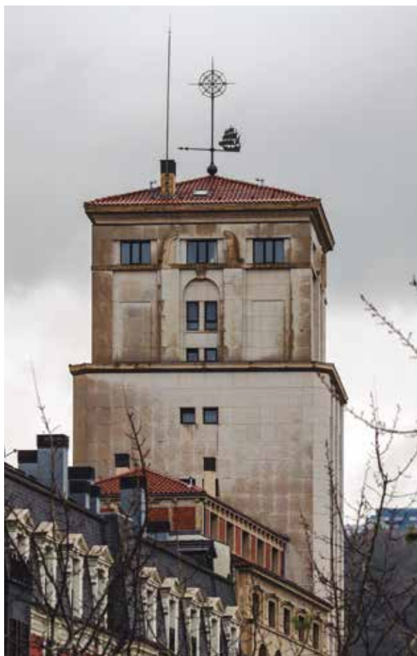
Bailén kaleko etxe orratza, Bilbo. Chapa y Galíndez, 1940. Rascacielos de la calle Bailén, Bilbao. Chapa y Galíndez, 1940.
